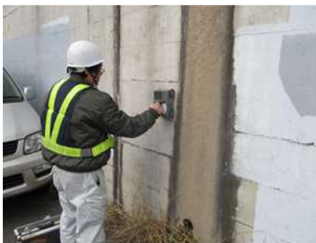
【鉄筋探査の作業状況】
