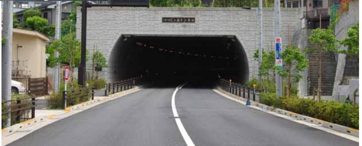
長房町側坑口
