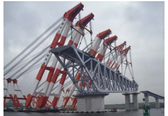
図-3 側径間架設状況
