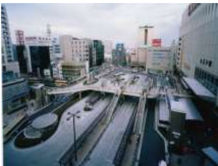
八王子駅北口駅前広場 (駅前広場・デッキ・地下駐輪場)
