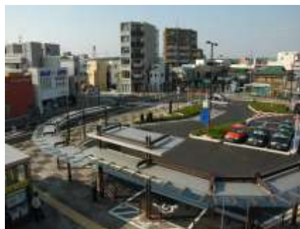
東村山駅西口駅前広場 (駅前広場・地下駐輪場)
