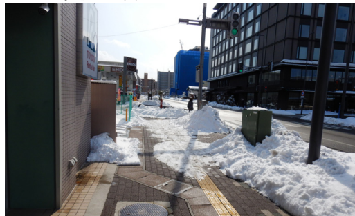
図-2 地上機器まわりに堆雪した歩道
