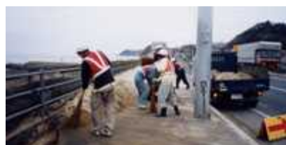
撤去作業（国道9号）
