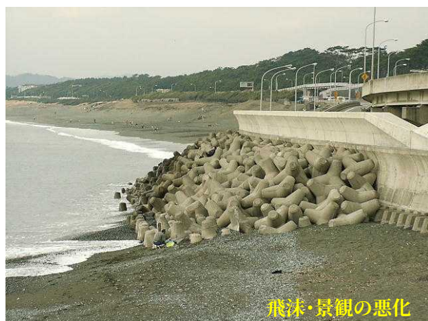
従来の対策（消波工・波返し工）
