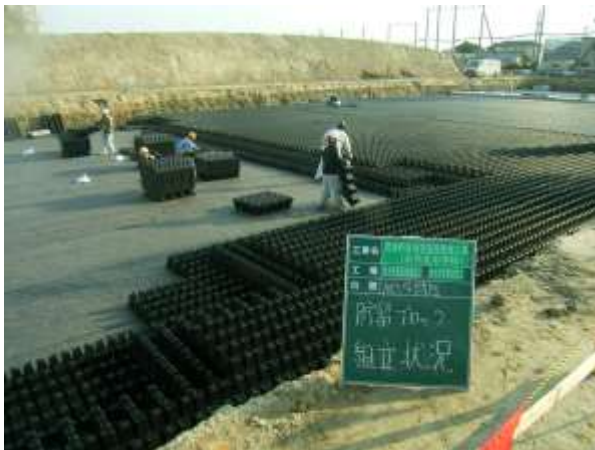
貯留ブロック組立作業時
