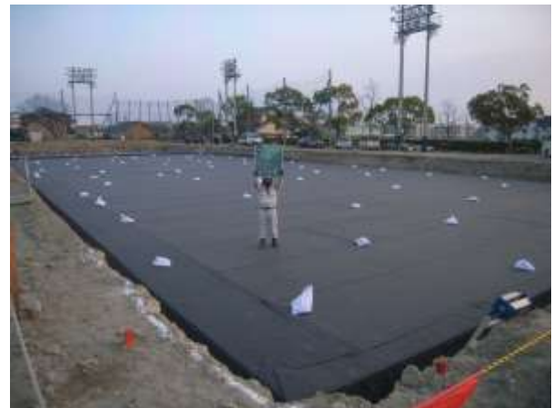
保護シート布設時
