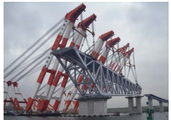
図－２ 側径間架設状況
