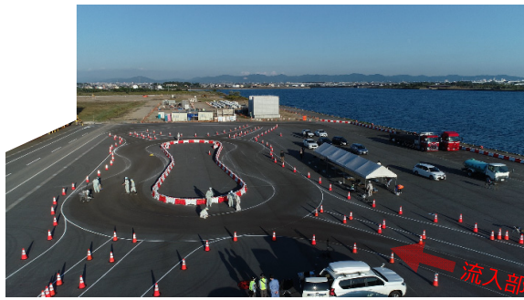
図7 仮設ラウンドアバウトの設置作業風景
