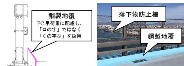
写真-4 鋼製地覆及び落下物防止柵設置状況
