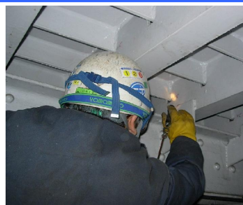
写真-2 目視点検状況 (鋼床版縦-横リブ)
