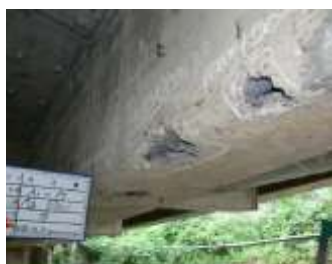
主桁（剥離・鉄筋露出）
