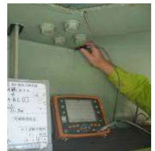
写真-3 過流探傷試験状況
