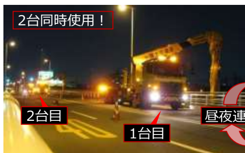
写真-1 (大阪)伝法大橋夜間点検状況
