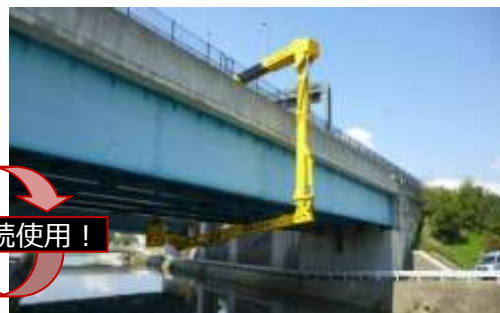
写真-2 (京都)洛南古川橋昼間点検状況
