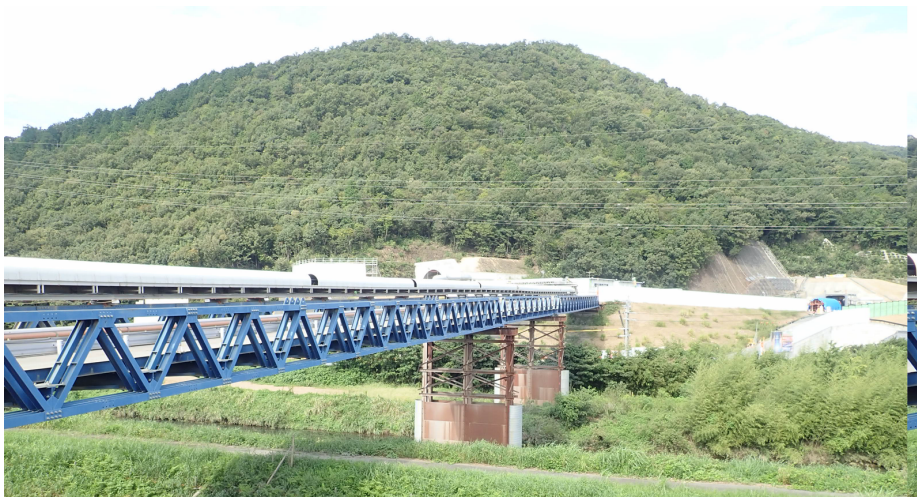
施工中の椿洞トンネル
