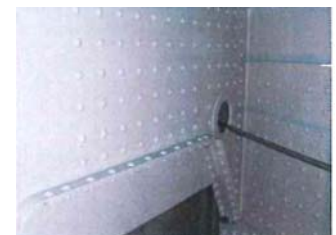
写真-6 本施工完了
