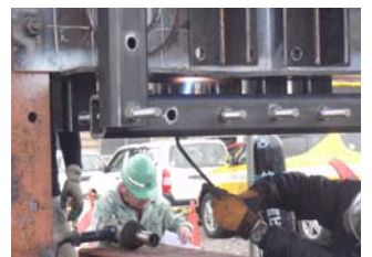
写真-4 試験施工状況
