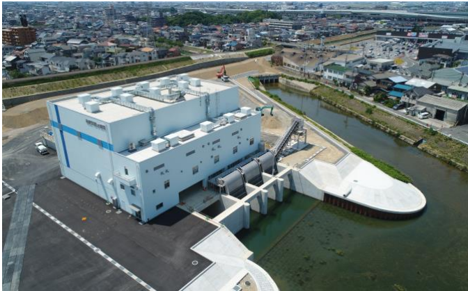
【建設直後の様子（一部工事中）】
