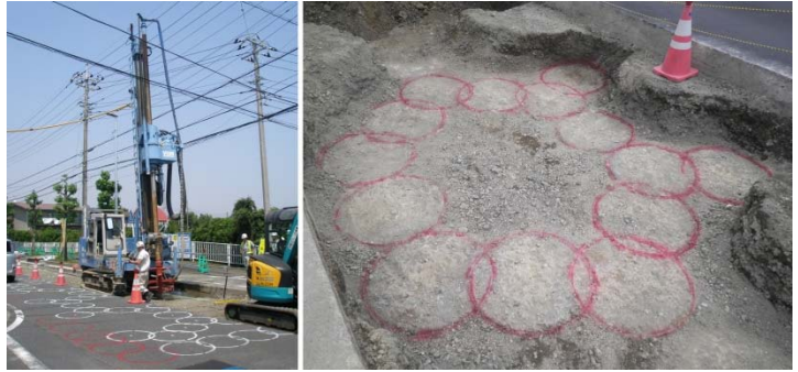
(a) 施工機械 (b) 地盤改良杭のセル出来形
