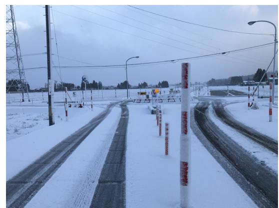
図-29 除雪基準値（15cm）以下の積雪時写真
