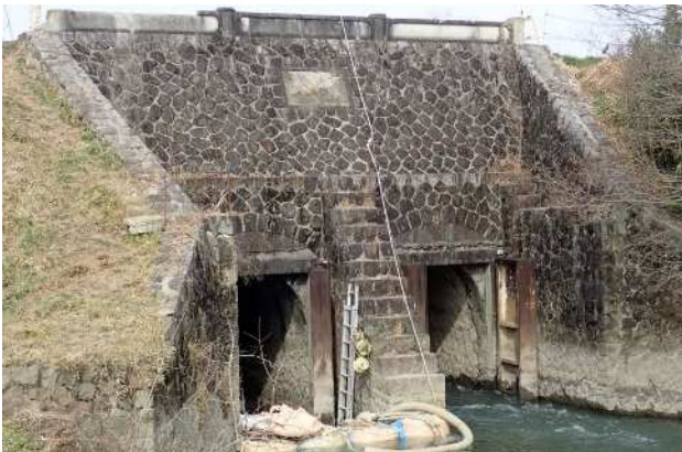
図-1 五六閘門（下流正面より）
