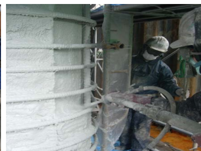
写真-5 ポリマーセメント吹付状況
