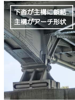
写真-2 橋脚部の支承
