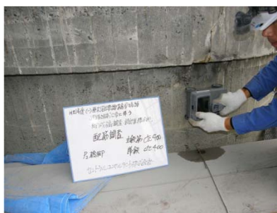
写真-4 配筋調査(探査)の状況
