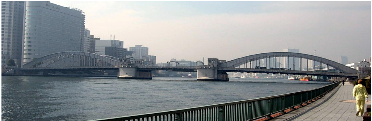
写真-1 勝鬨橋（東京都中央区）
