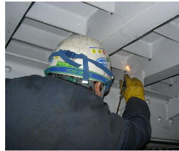
写真-2 目視点検状況 (鋼床版縦・横リブ)
