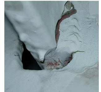
写真-3 磁粉探傷試験実施部 (スカラーアップ)
