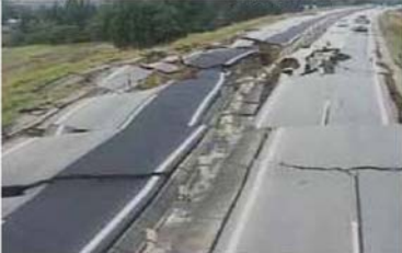
(道路の被災と復旧/国交省道路局より)
