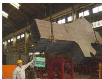
図-10 実物大製作施工性試験
