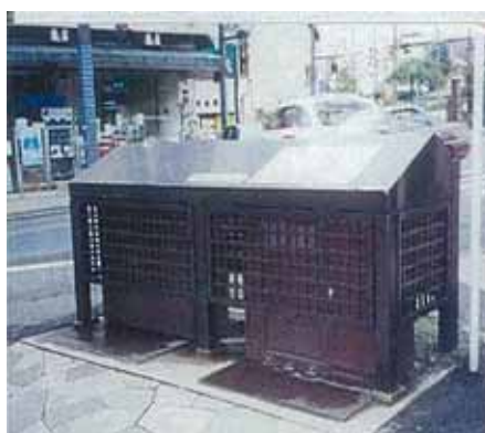
<電力地上機器を案内板の下に設置して、景観に配慮した参考事例：京都府宇治市>
