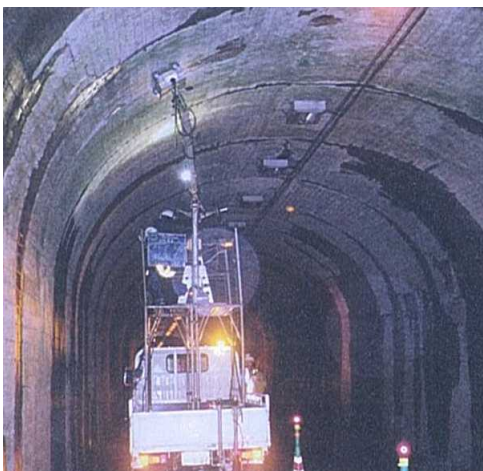
電磁波法による覆工調査
